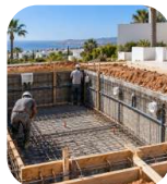
De la fouille à la mise en eau, nos équipes réalisent chaque phase du bassin.
