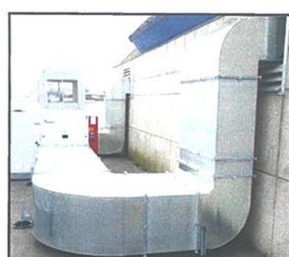
Gaine de ventilation préisolé
