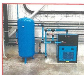
Installation et traitement
